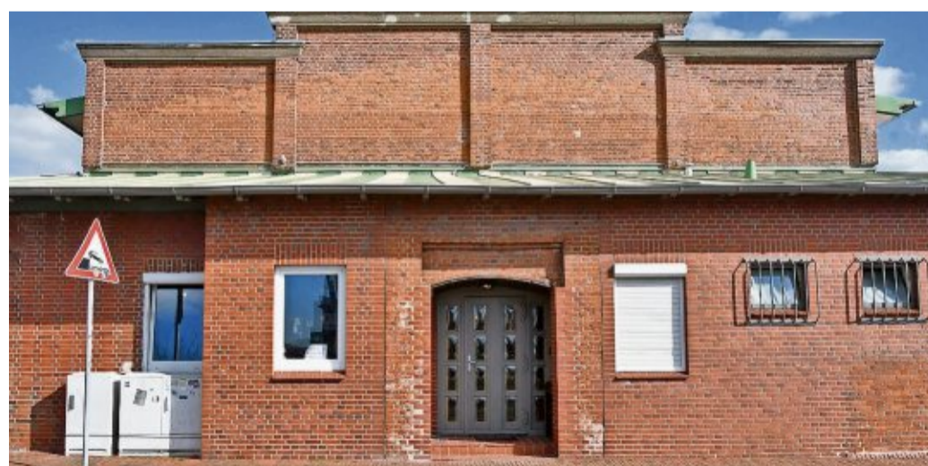
Noch nicht ganz fertig ist der Eingangsbereich des „Krohn's Eck“.
