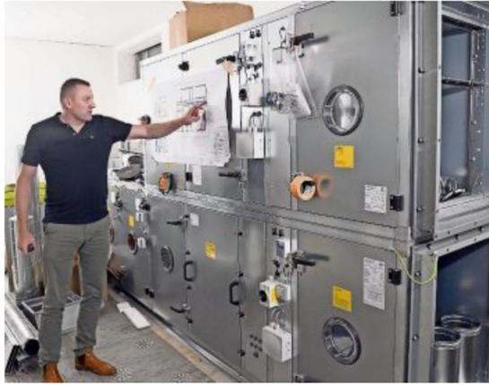
Dirk Thies zeigt die Druckerhöhungsanlage. Sie wird immer frische Luft in Fluchttreppenhäuser blasen. FOTO: SCHEER
