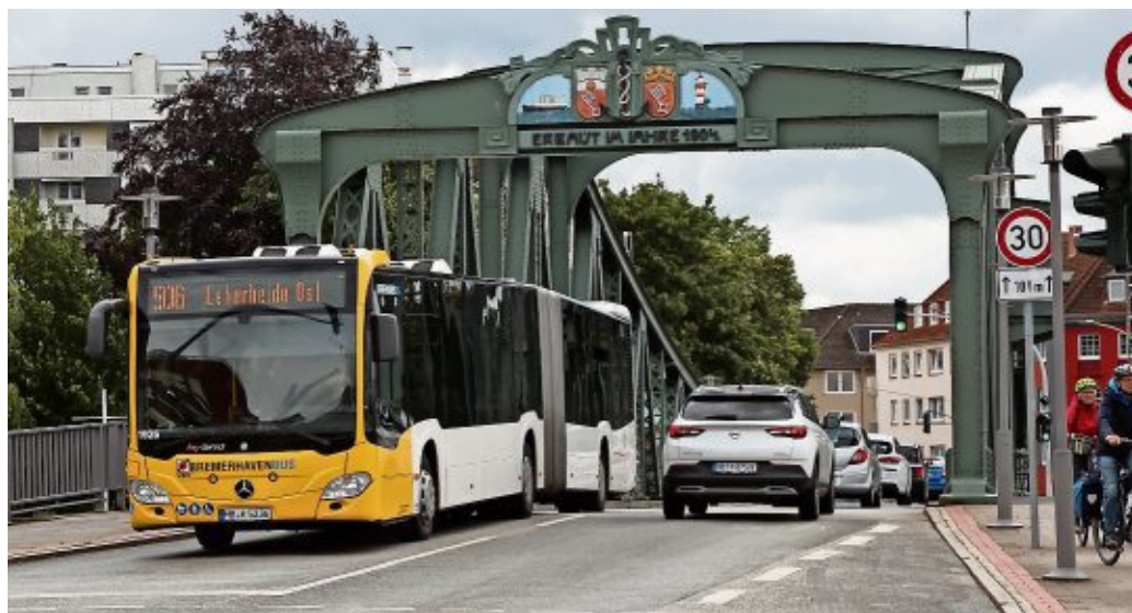
Künftig sollen keine Busse mehr über die Alte Geestebrücke fahren.
