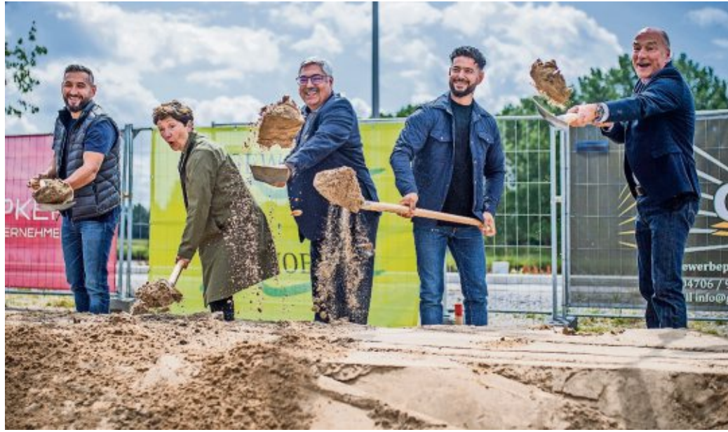
Spatenstich am Kistner-Gelände (von links): Jaroslav Gerbatowski, Ingrid Spengler, Melf Grantz, Silvester Gerbatowski und Christian Jäger. FOTO: HARTMANN
