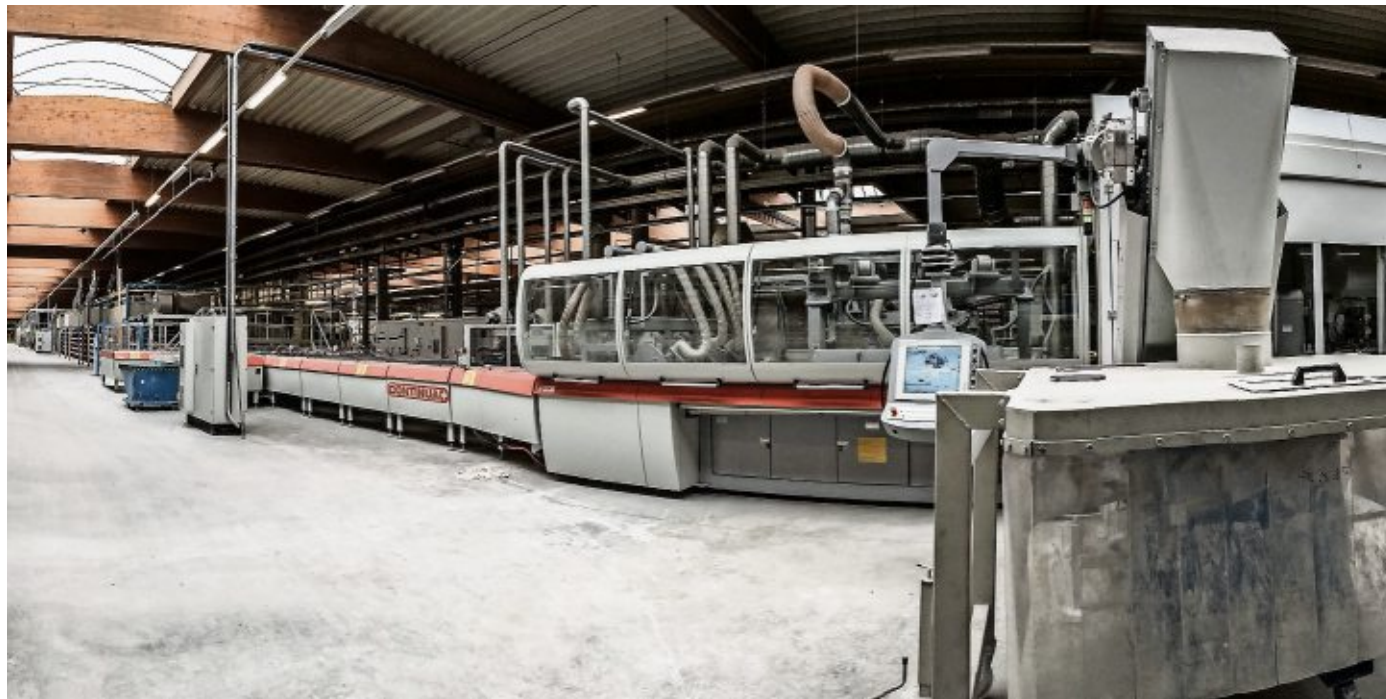
135 Meter lang ist ein Ofen in der Fabrik von Nordceram im Bremerhavener Fischereihafen. Hier werden normalerweise rund um die Uhr Wand- und Bodenfliesen hergestellt. FOTO: STEULER FLIESENGRUPPE AG
