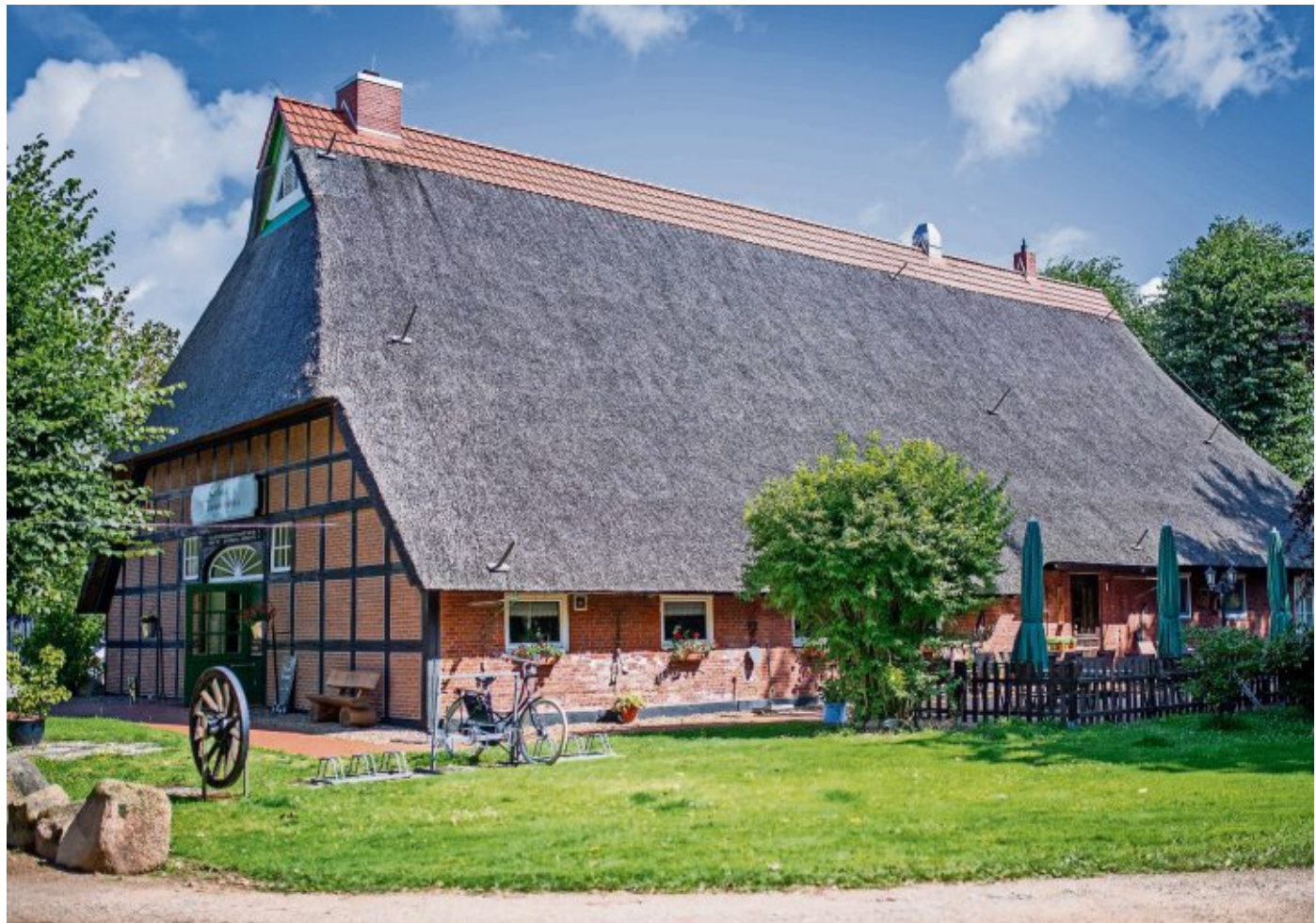
Gute Nachrichten für das Wulsdorfer Buernhus kann die Bürgergemeinschaft Wulsdorf verkünden. Sie investiert in eine neue Heizungsanlage und Türrestaurierung. FOTOS: HARTMANN
