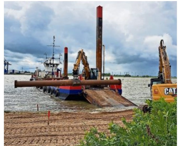
60.000 Kubikmeter Sand aus der Weser werden am Ufer in Sandstedt verteilt. FOTO: IVEN
