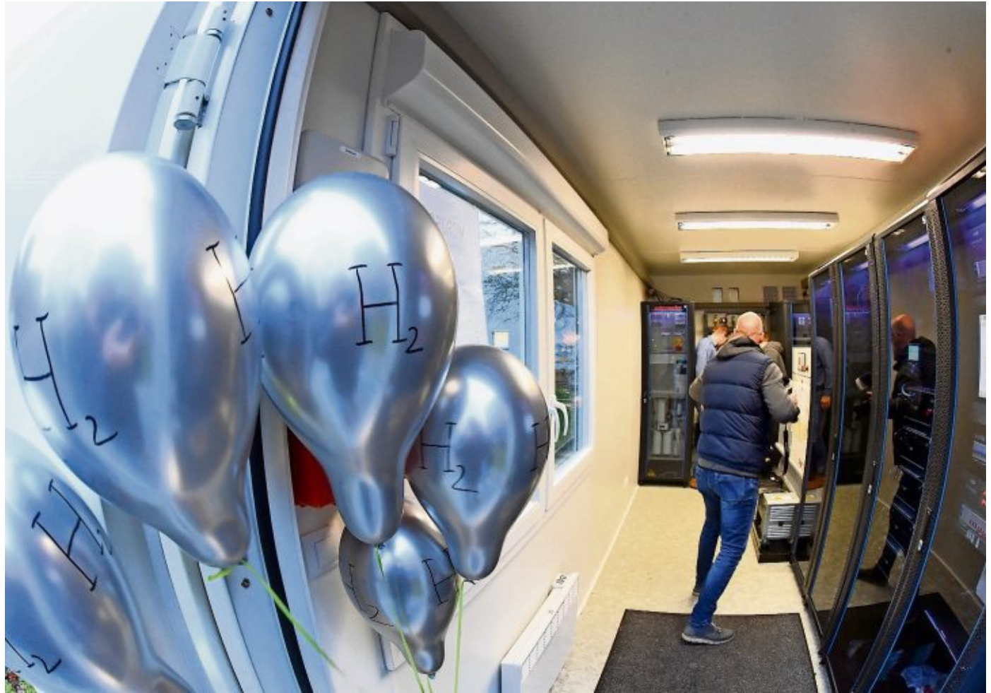
Die Hochschule hat unter anderem in der Teilstudie „Microgrids“ einen Container zu einer Versuchsanlage umgebaut. FOTO: SCHEER
