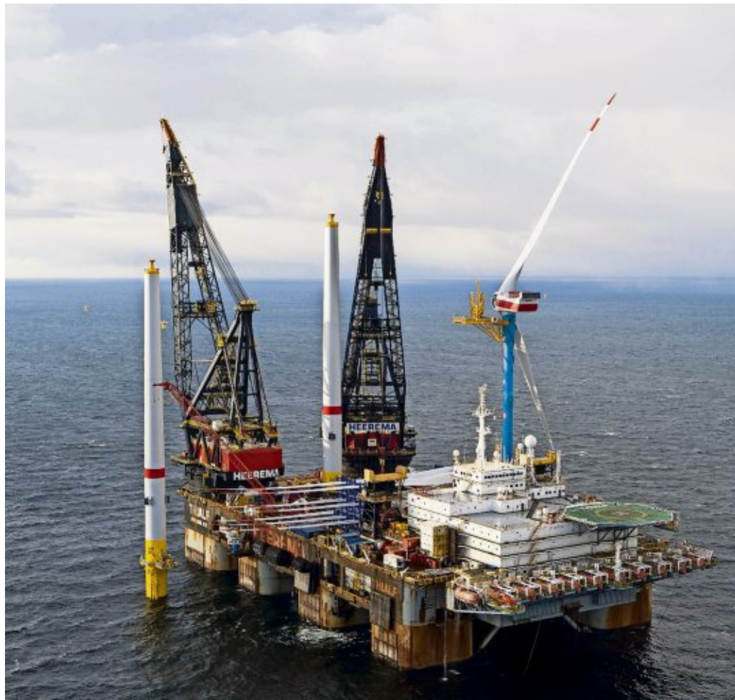
Anlageninstallation im Offshore-Windparks Arcadis Ost 1.
