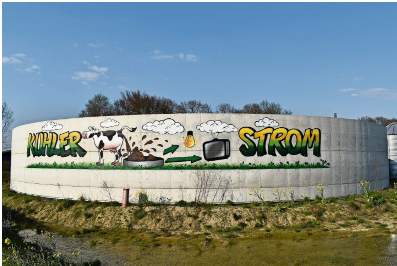
Eine Biogas-Anlage kann auch klimaneutralen Strom produzieren, wie dieser Cartoon hier an einem Güllebehälter in Sellstedt deutlich macht. FOTOS: HANSEN
