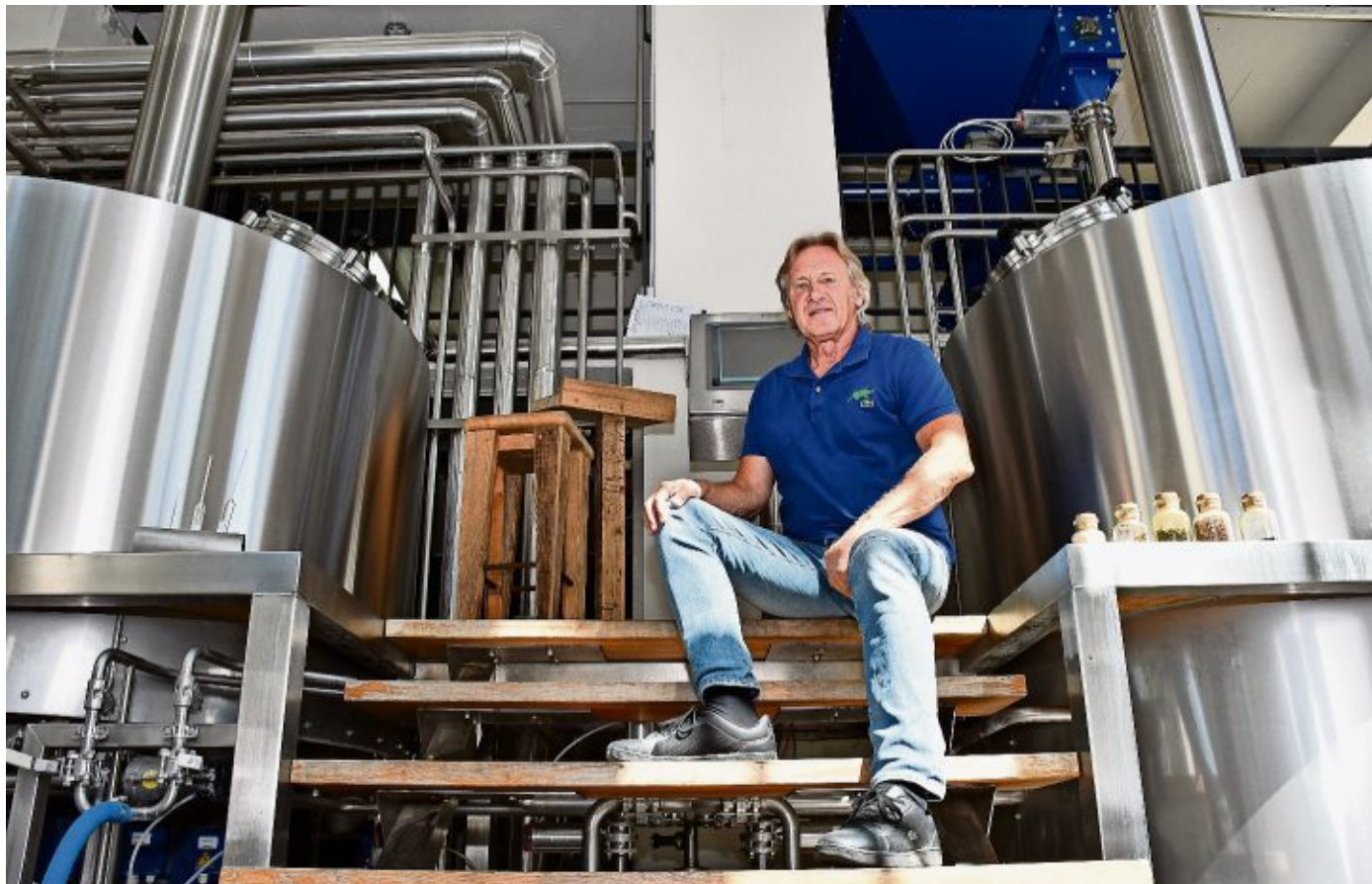
Lüder Kastens, Chef der Union-Brauerei, im Sudhaus zwischen den Braukesseln. Mit solchen Kesseln will er auch in Bremerhaven Bier herstellen, wenn der Umbau des ehemaligen Koggenbräu abgeschlossen sein wird.
