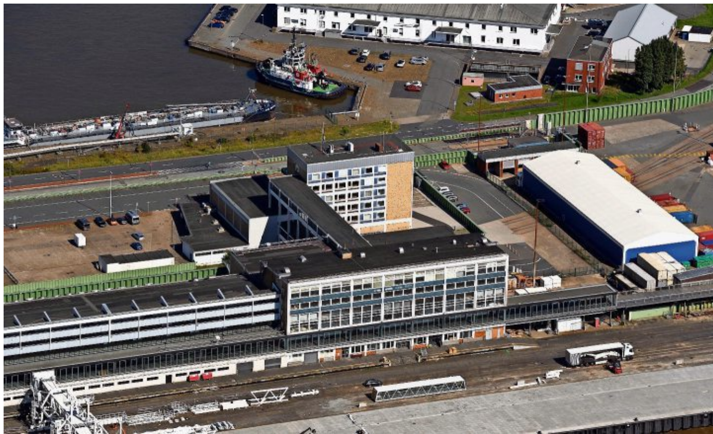
Eigentlich sollte der Columbusbahnhof abgerissen werden und einem Neubau weichen. Das ist wohl vom Tisch. FOTO: SCHEER
