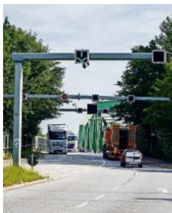
Die Grimsbystraße zwischen Freigebiet und Stresemannstraße wird ab Montag voll gesperrt. FOTO: GEIMER/MAGISTRATSPRESSESTELLE
