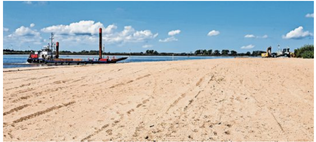
Strand, Strand, Strand, soweit das Auge reicht. In Sandstedt wurden 60.000 Kubikmeter Sand aufgespült.
