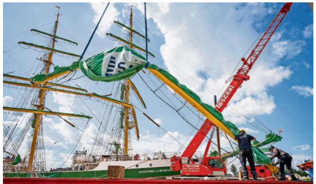
Die defekten Rahen der „Alexander von Humboldt II“ werden an der Labradorkaje abgenommen. Aber der Abbau gestaltete sich schwierig. FOTO: SCHESCHONKA
