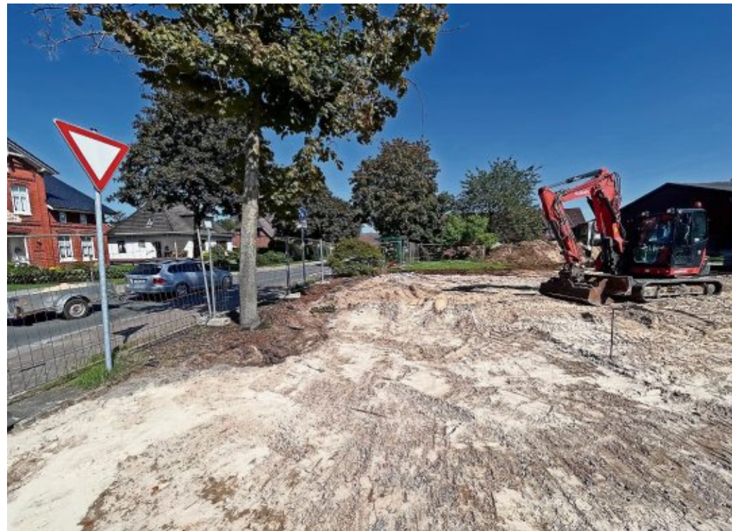
Die Handwerker haben mit den vorbereitenden Arbeiten für die smarte Dorfmitte in Neuenwalde begonnen. FOTO: HINKELMANN/STADT GEESTLAND
