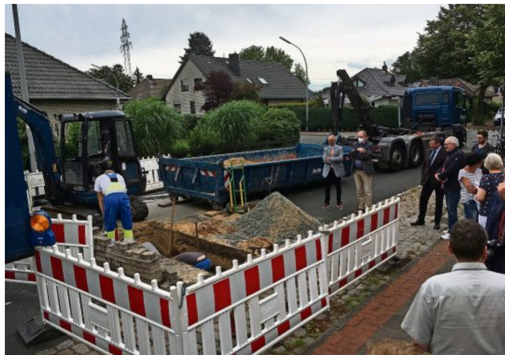
Um den vom Grundwasseranstieg betroffenen Hausbesitzern zu helfen, war in der Flettnerstraße 2021 ein Versuchsbrunnen in Betrieb genommen worden. Ziel: Den Grundwasserspiegel im Gebiet drumherum absenken. Der Brunnen wird jetzt wieder abgestellt.
