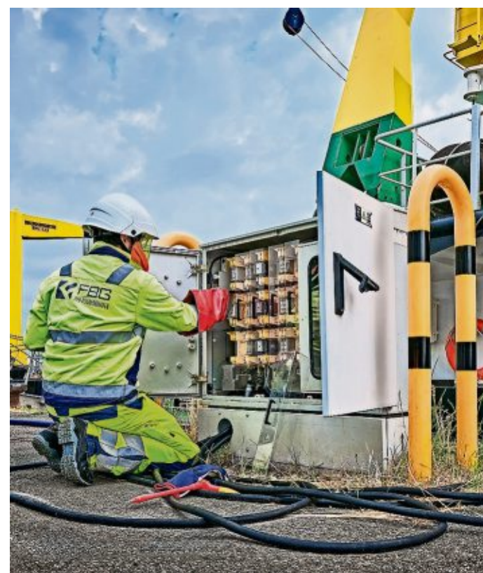
Ein FBG-Mitarbeiter legt einen Landstromanschluss.
