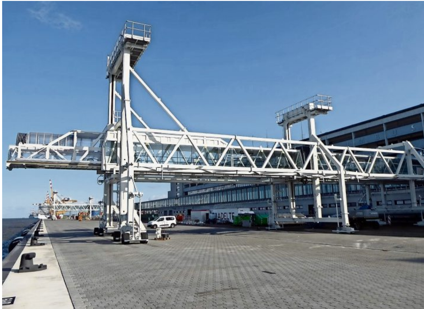
Die neuen Passagierbrücken bestehen aus zwei verglasten Tunnelabschnitten.
