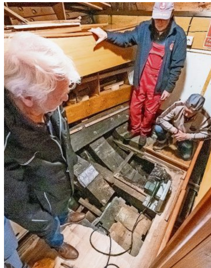
Genau an dieser Stelle ist die Kogge durch die Havarie beschädigt. Durch die Planken dringt noch immer Wasser ein. FOTO: SCHESCHONKA
