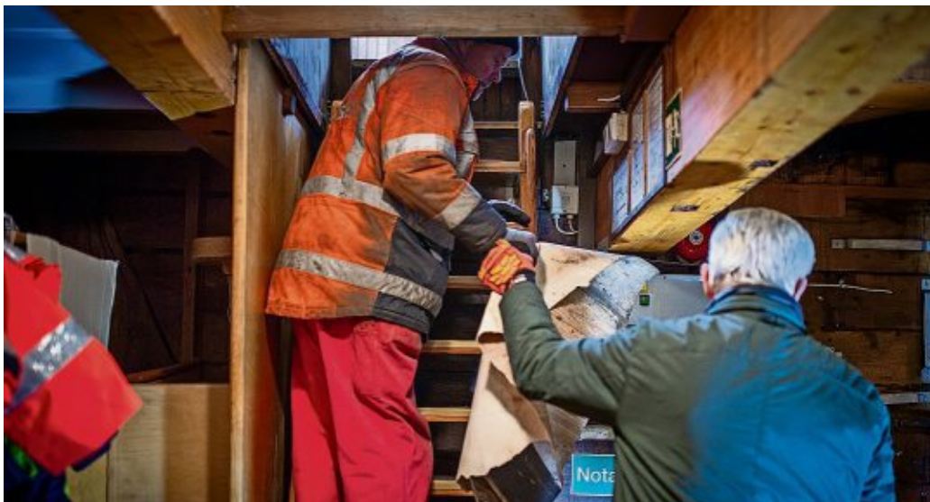
Joachim Beermann und Reiner Monsees (links) entfernen den Bodenbelag der Kogge unter Deck.
