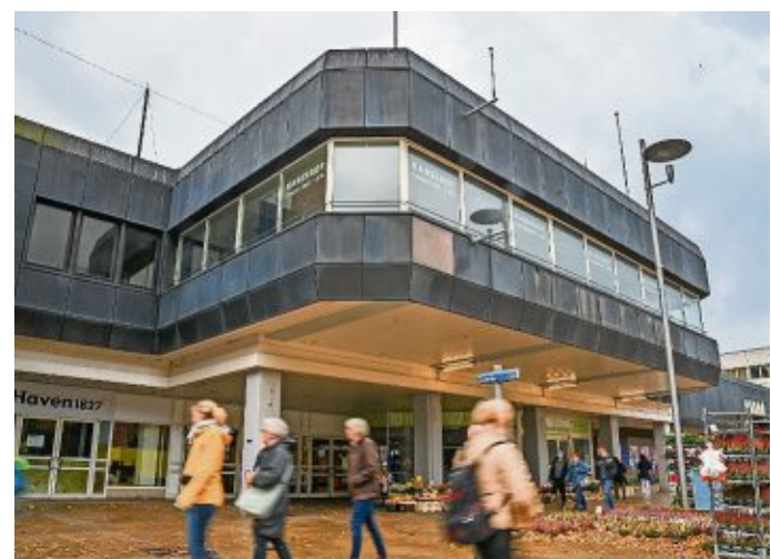
Durch den Karstadt-Abriss werden die Kunden die Geschäfte der Oberen Bürger nicht mehr so gut erreichen können.
