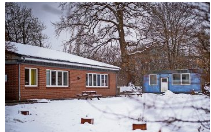
Hier soll das Gebäude für den Zoll entstehen. Die bundeseigene Fläche liegt an der Straße Am Leher Güterbahnhof 16. FOTO: HARTMANN
