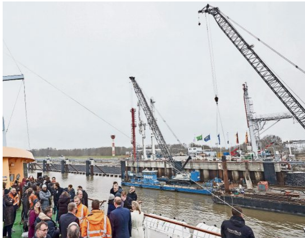
Nach elf Monaten Bauzeit ist der Anleger für das schwimmende Terminal für Flüssigerdgas (LNG) an die Nutzer Deutsche Energy Terminal und Hanseatic Energy Hub übergeben worden. FOTO: WENDT/DPA
