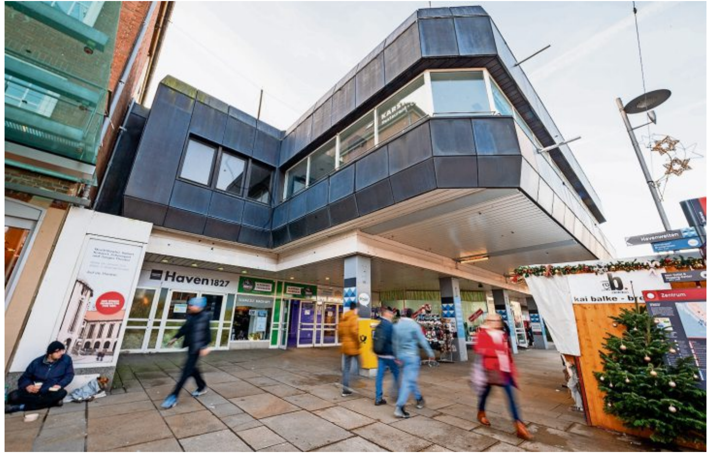
Mitte Januar beginnen die Arbeiten zum Abriß des Karstadt-Gebäudes.
