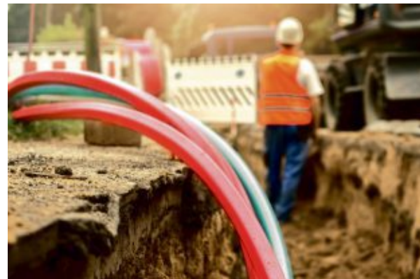
Moderne Glasfaserleitungen werden verlegt.
