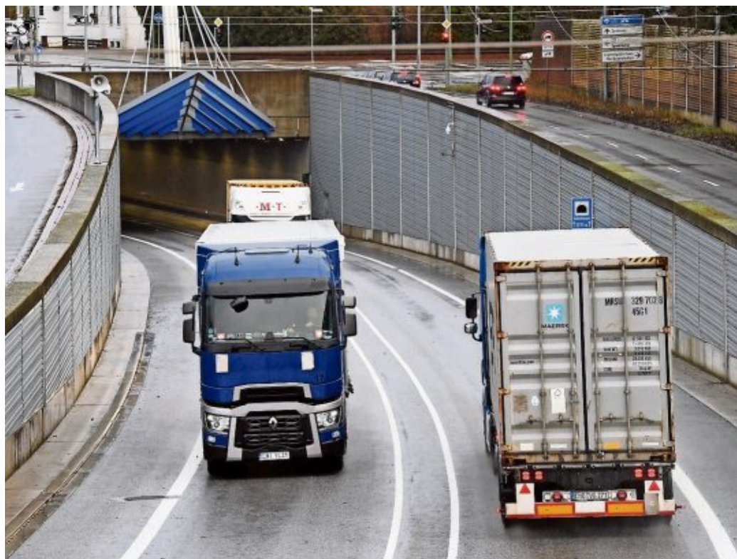
Der Hafentunnel ist jetzt offen - im vier Wochen dauernden „Einfahrbetrieb“ sind aber immer noch Sperrungen möglich. FOTO: SCHEER
