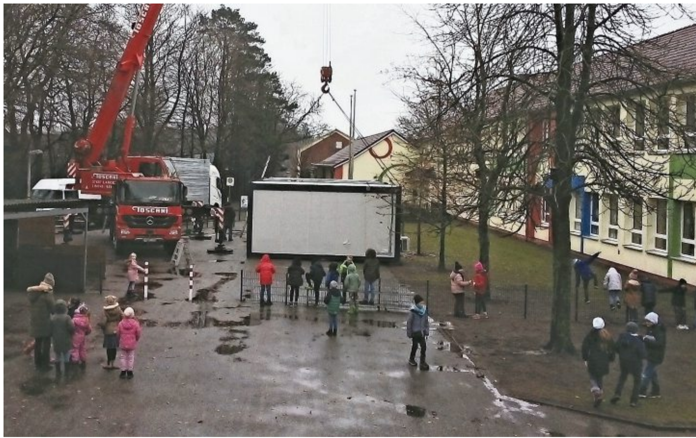
Millimeter-Arbeit in Neuenwalde: Ein Kran lässt herunter, was die beengte Klassenraumsituation in der Grundschule lindern soll. FOTO: PR
