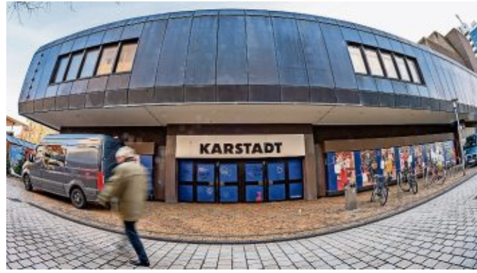
Das ehemalige Karstadt-Gebäude wird abgerissen. FOTO: SCHESCHONKA
