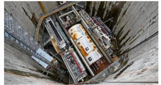
Tunnelbohrmaschine „Hermine“ wurde im November getauft und soll einen 1,2 Kilometer langen Tunnel unter der Elbe bohren. Dieser wird der Fernwärmeversorgung dienen.
