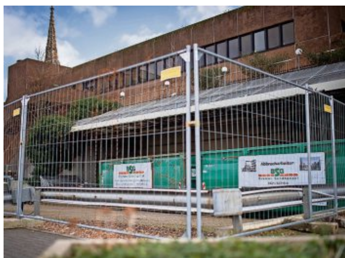
Die Abbrucharbeiten am ehemaligen Karstadt-Gebäude in der Innenstadt haben begonnen - noch finden sie im Inneren statt. Mit Bauzäunen wurde der Komplex umschlossen. FOTO: HARTMANN
