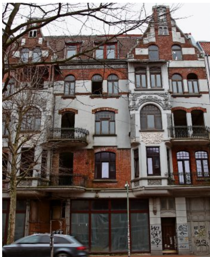
Schrott-Immobilie an der Hafensstraße 42: Die Stadt nimmt eine Ersatzmaßnahme vor. FOTO: GEHRKE
