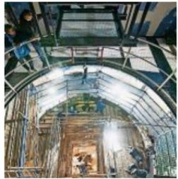
20 Meter lang ist der Schacht, den Bauarbeiter durchs Klimahaus getrieben haben. In ihm bewegt sich später die Hubplattform, die Besucher durch die neue Extremwetter-Ausstellung trägt.
