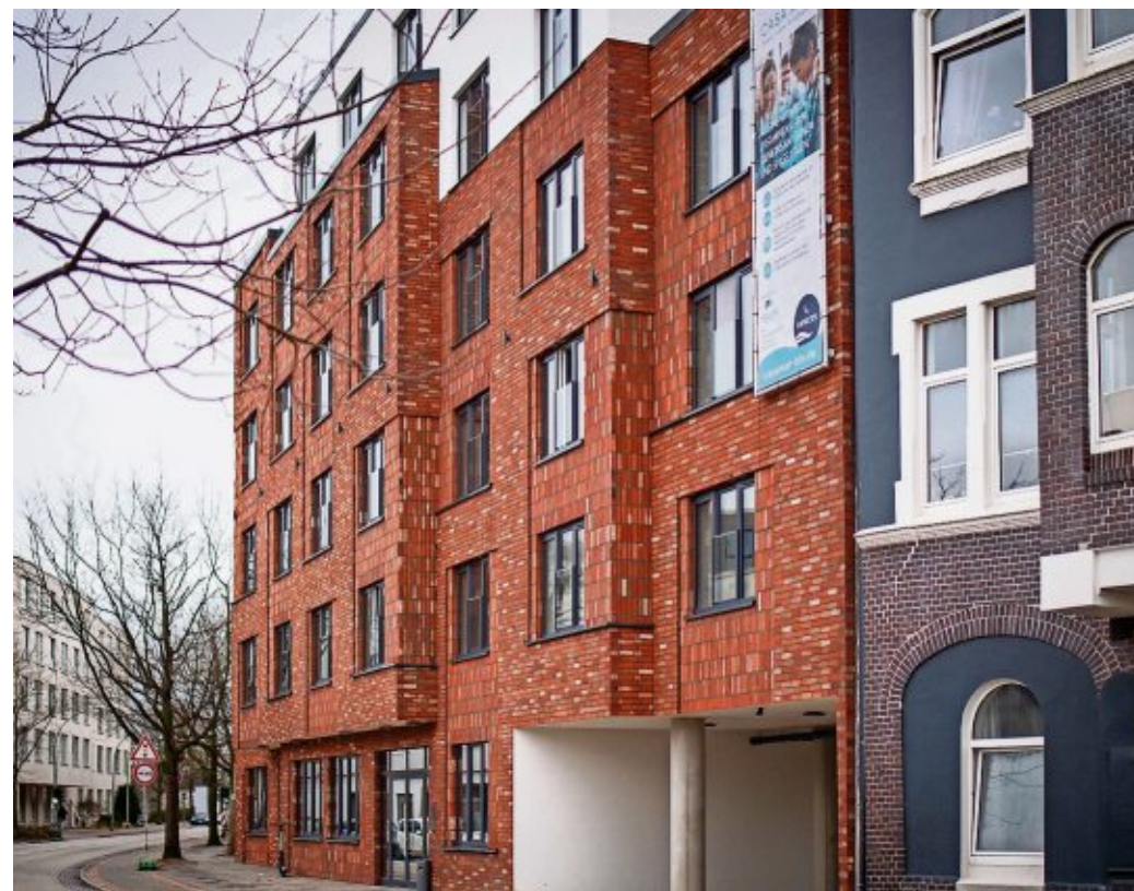
Neubau in bester Lage: Einweihung des Studenten- und Azubiwohnheims in der Bremerhavener Deichstraße. FOTO: HARTMANN
