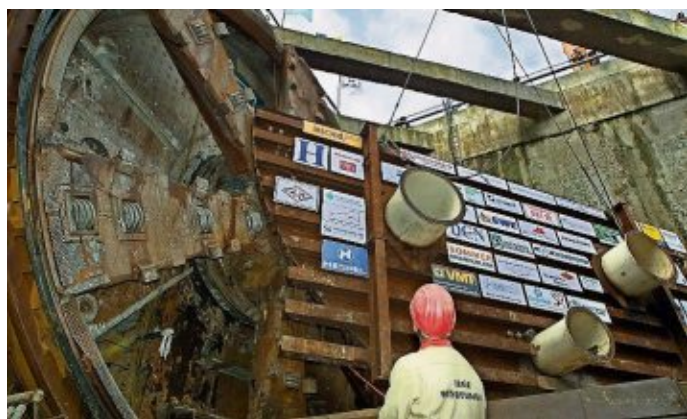
Ein Arbeiter dirigiert am 7. November 2001 während der Durchstichfeier der zweiten Röhre die Demontage des sogenannten Zieltopfdeckels. Hinter dem Deckel ist bereits das Schneidwerkzeug des Tunnelbohrers sichtbar. Foto: Wagner/dpa
