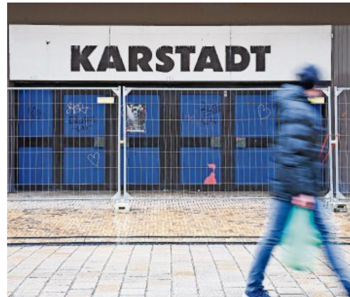
Das ehemalige Karstadt-Gebäude wird abgerissen. FOTO: SCHESCHONKA
