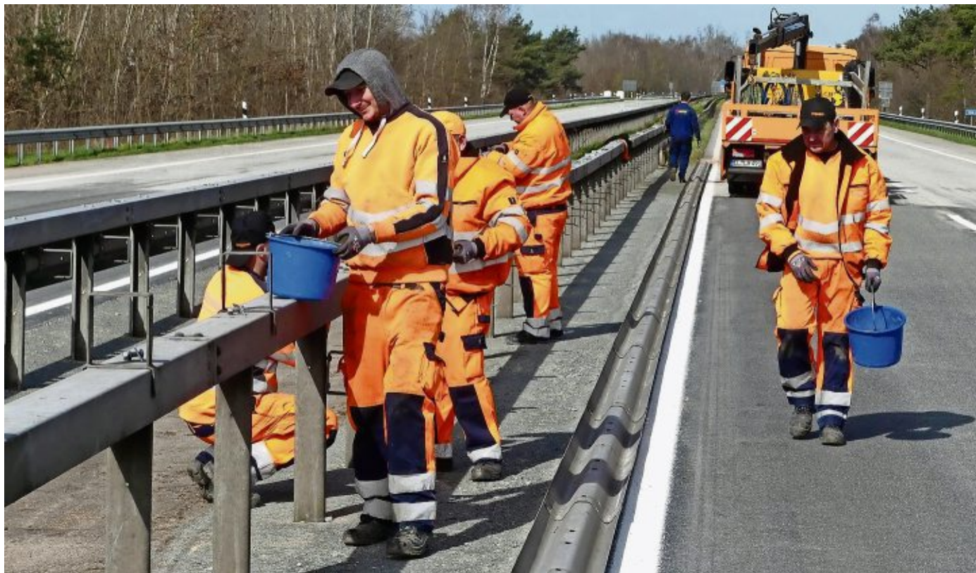
Am letzten Tag vor der Freigabe der A 27 bei Hagen haben die Bauarbeiter noch einiges zu tun.
