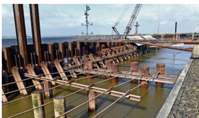
Komplizierte Konstruktion: Die letzten beiden Stahlbohlen werden erst in die Tiefe getragen, wenn die Fläche dahinter mit Sand gefüllt ist. Sie bleiben oben, damit das Wasser abfließen kann. FOTO: SCHEER
