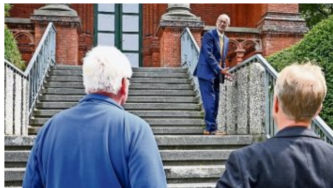
Die Treppe hinauf zur Friedhofskapelle Wulsdorf ist für Menschen mit Gehbehinderung oft nicht zu schaffen. Baudezernent Bernd Schomaker nimmt die Situation mit Holger Schneeberg (rechts) und einem Experten von Seestadt-Immobilien in Augenschein.
