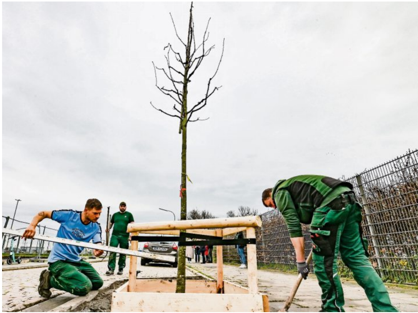
In der Hansastrasse werden drei Zerreichen als stadtweit erste Straßenbäume gepflanzt. Vor Kurzem schaufelten hier am Rande des Hafens Pascal Gübel, Lars Klingebiel und Nils Koch (von links) von der städtisch beauftragten Firma Grewe. FOTOS: SCHESCHONKA
